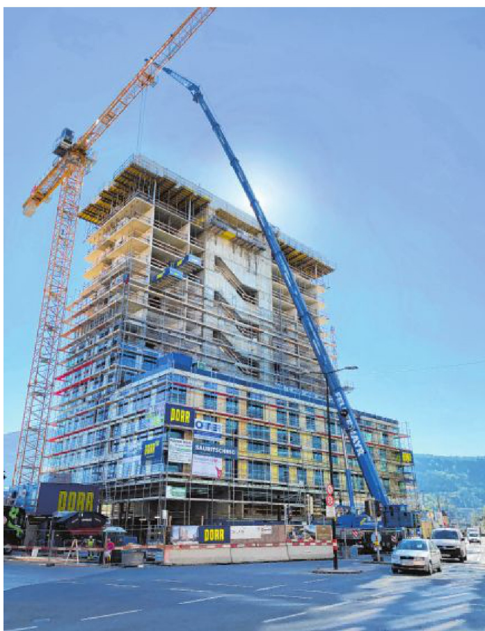
Der Pema-Turm „P3“ am Innsbrucker Hauptbahnhof hat mit 48 Metern seine finale Bauhöhe erreicht.
